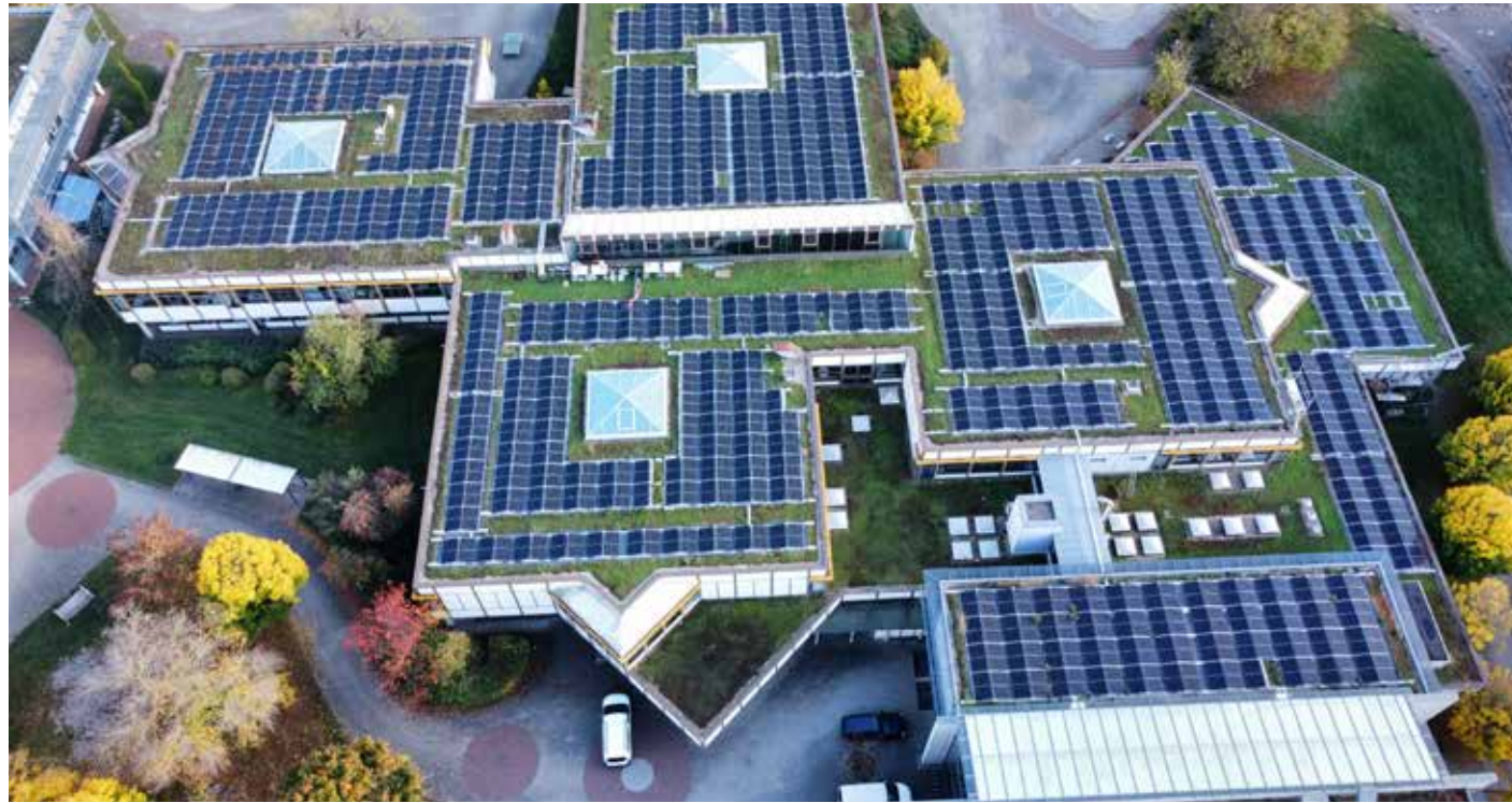
Mit einer Drohne aufgenommen: Die PV-Anlage auf dem Dach des Schulzentrums Ost.
