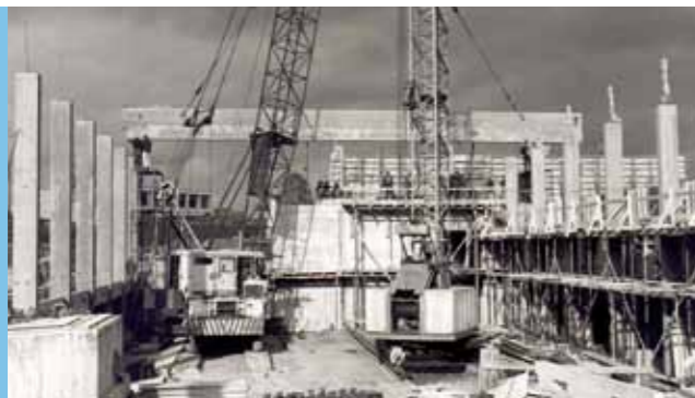
Schenkensee-Hallenbad im Bau, Herbst 1970
