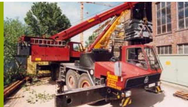
Einbau des Abhitzeessels, 1993
