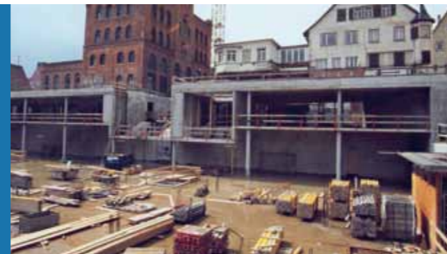
Baustelle Parkhaus Löwenbrauerei
