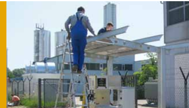
Bau der Erdgastankstelle
