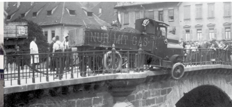
Henkersbrücke, Unfall eines LKW des Gaswerks, 1927
