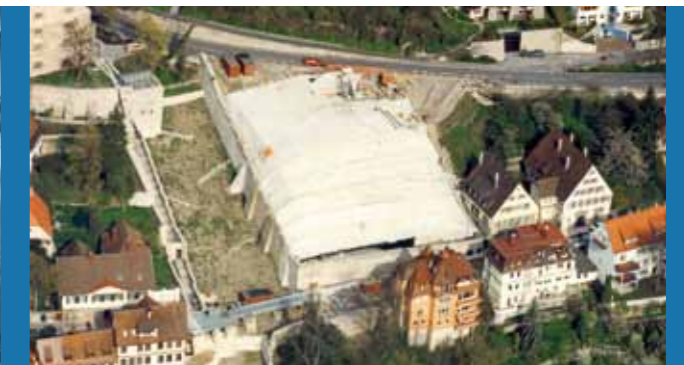
Baustelle Parkhaus Schiedgraben, Luftbild
