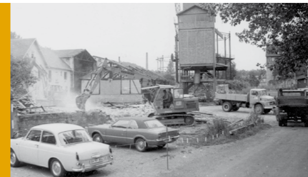
Abbruch Gaswerk Salinenstraße, 1971
