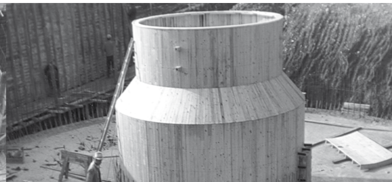
Bau der Flusswasseraufbereitungsanlage Cyclator, 1966
