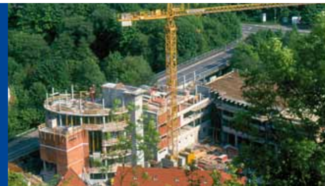
Bau der neuen Zentrale, 1998
