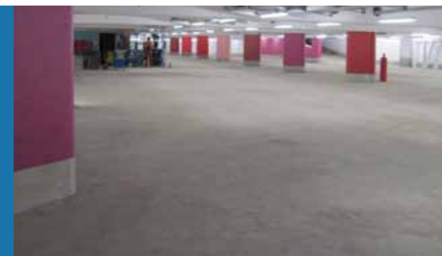
Tiefgarage mit farblich akzentuierten Betonstützen
