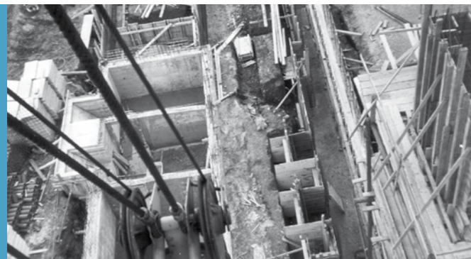
Bau der Flusswasseraufbereitungsanlage, 1966
