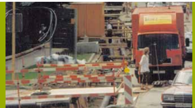
Verlegung von neuen Leitungen in der Katharinenstraße
