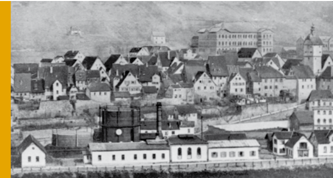
Vorderansicht des Gaswerks, 1903
