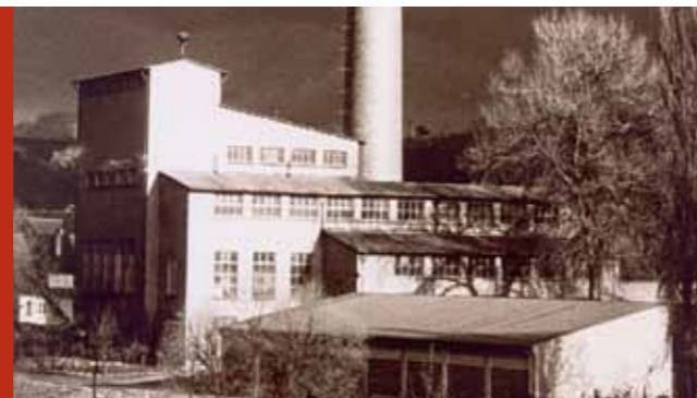
Heiz-Kraftwerk evangel. Diakoniewerk
