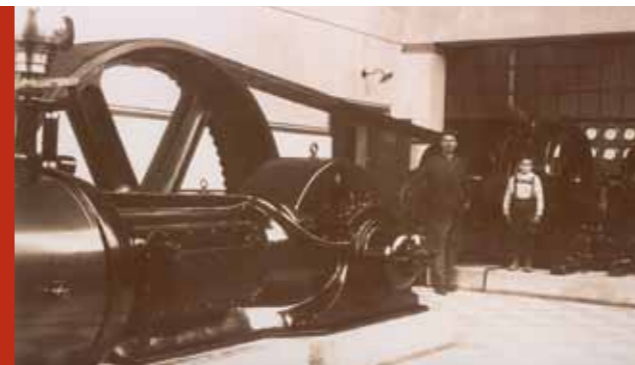
Heiz-Kraftwerk evangel. Diakoniewerk
