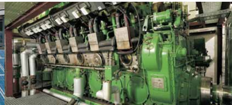
Motor Pflanzenöl-Kraftwerk
