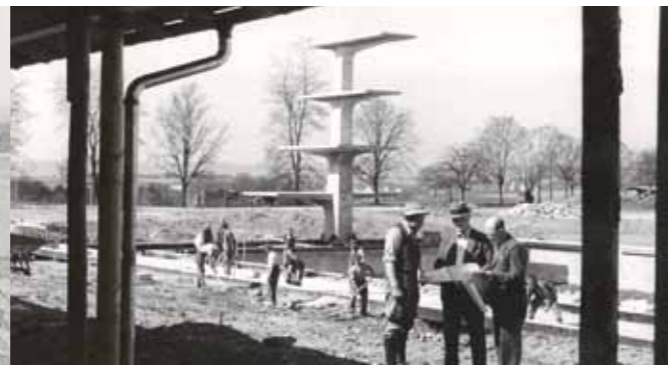
Schenkenseefreibad im Bau, um 1942
