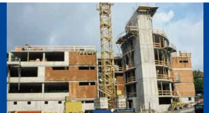
Bau der neuen Zentrale, 1998
