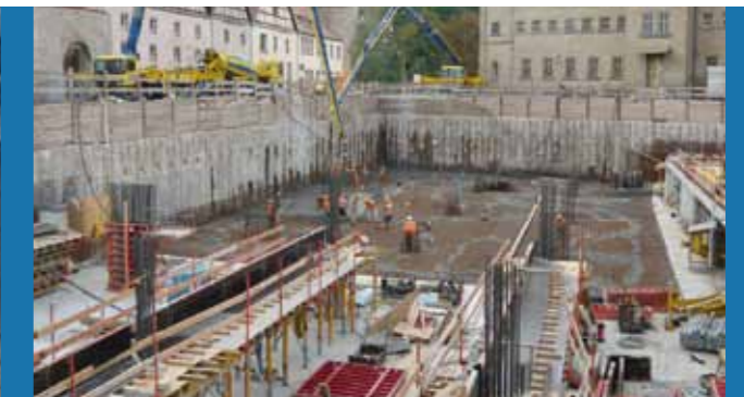
Parkhaus Kocherquartier, Bodenplatte wird betoniert, 2008
