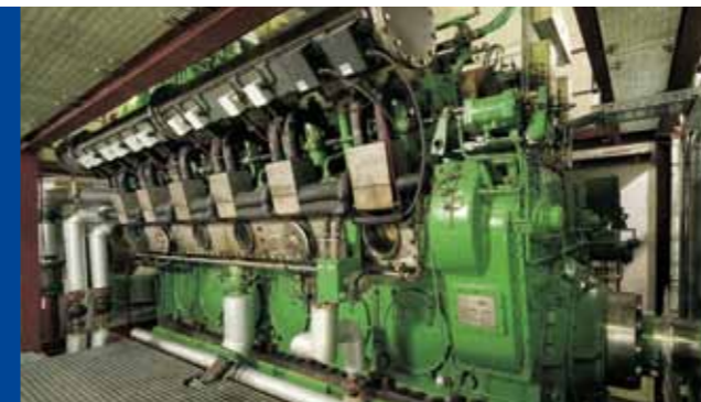
Motor Pflanzenöl-Kraftwerk
