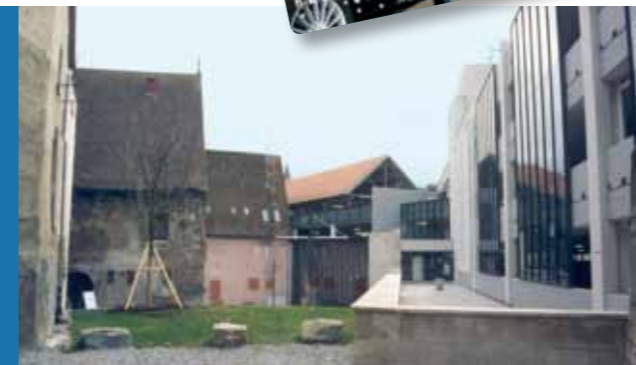
Parkhaus Ritterbrauerei, Handelshof
