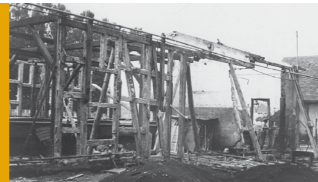
Abbruch Gaswerk Salinenstraße, 1971
