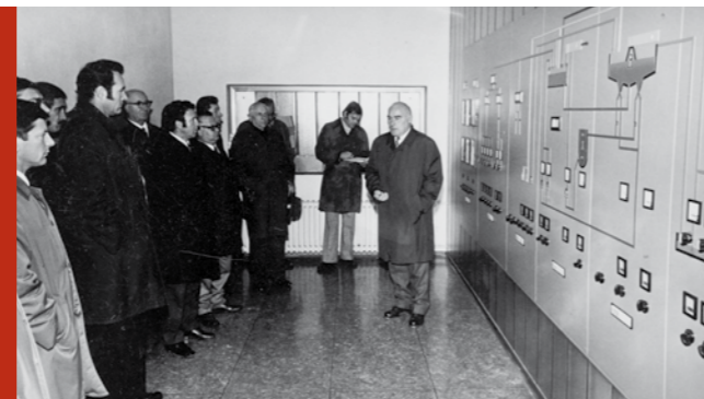
Gruppe in Steuerung Wasserwerk, Mitte: Ing. Erich Brucker
