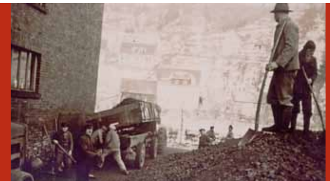
Kohlelieferung, Heiz-Kraftwerk evangel. Diakoniewerk
