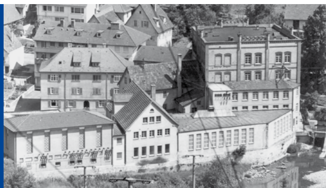
Mühle Heller, Stadtwerke, um 1950
